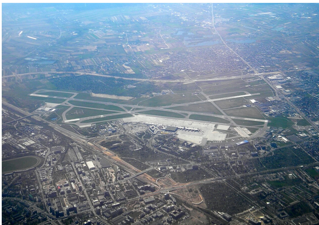
Widok lotniska z lotu ptaka w kwietniu 2012. Aerial view of the Okęcie Airport in Warsaw CC BY-SA 3.0 6
