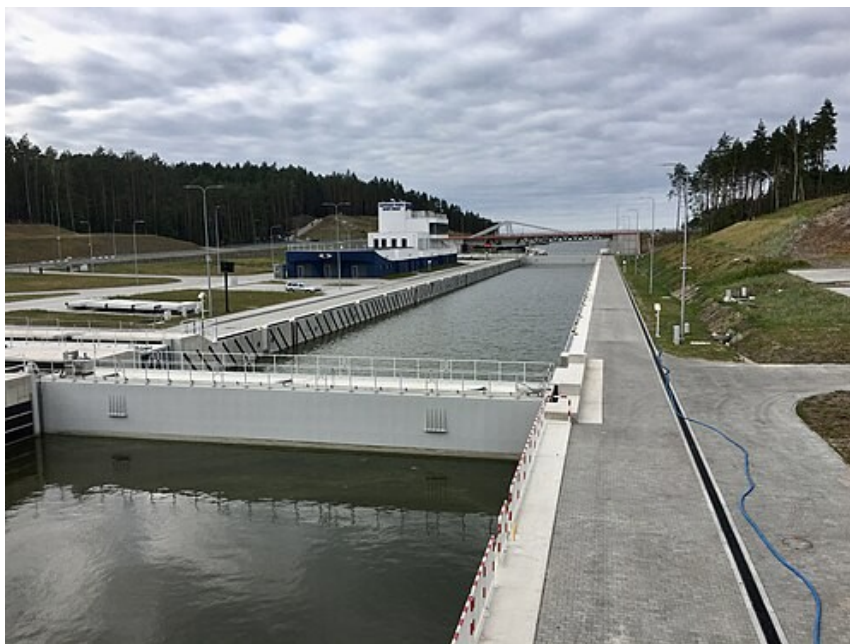
Kanał w trakcie prac wykończeniowych, lipiec 2022. CC BY-SA 4.0
