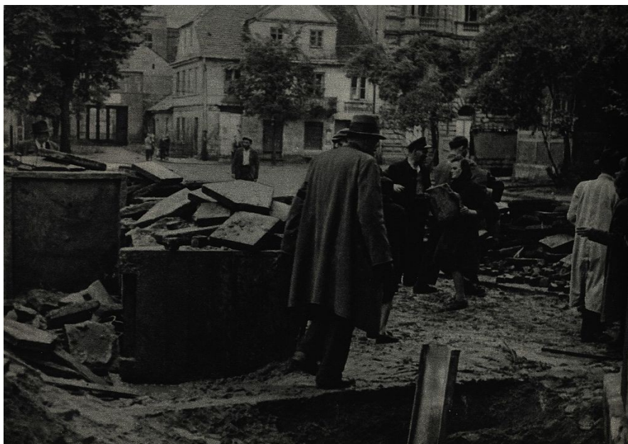
Budowa barykady na jednej z wolskich ulic. Autor nieznany. Domena publiczna.
